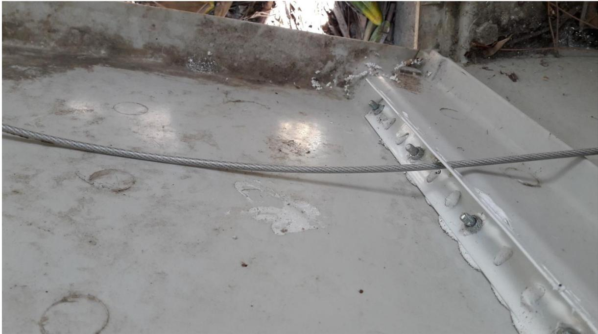
Figure 6 Dans la cornière côté charnière juste glisser le câble dans un trou à mi-hauteur
