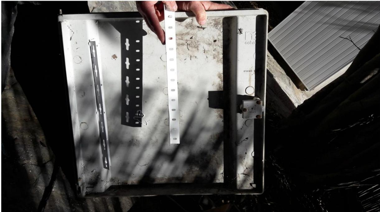
Figure 1. Vue intérieure de la porte du coffret compteur. De chaque côté de la porte il y a deux pans inclinés. Sur chacun de ces pans boulonner et coller une cornière métallique (en vente dans les magasins de bricolage), dans ce cas elles sont blanches. On voit l'ombre de celle de droite que je tiens en main.
