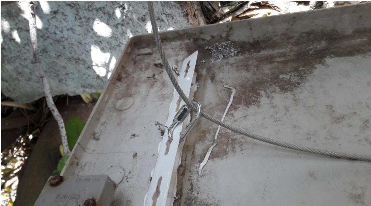
**Figure 5** Dans la cornière côté serrure placer un mousqueton dans lequel on glisse le câble acier (plastifié diamètre 4 mm) Ce câble doit être plastifié pour des raisons de sécurité électriques Il passe très près des fils EDF derrière le panneau en bois.
