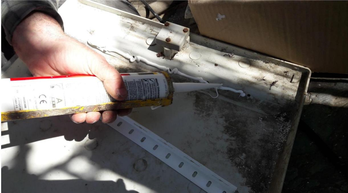
**Figure 2** Partie collage de la cornière après forage des trous pour les boulons (de poêlier) de diamètre 5 mm Les cornières renforcent la porte une fois boulonné et la colle sèche.
