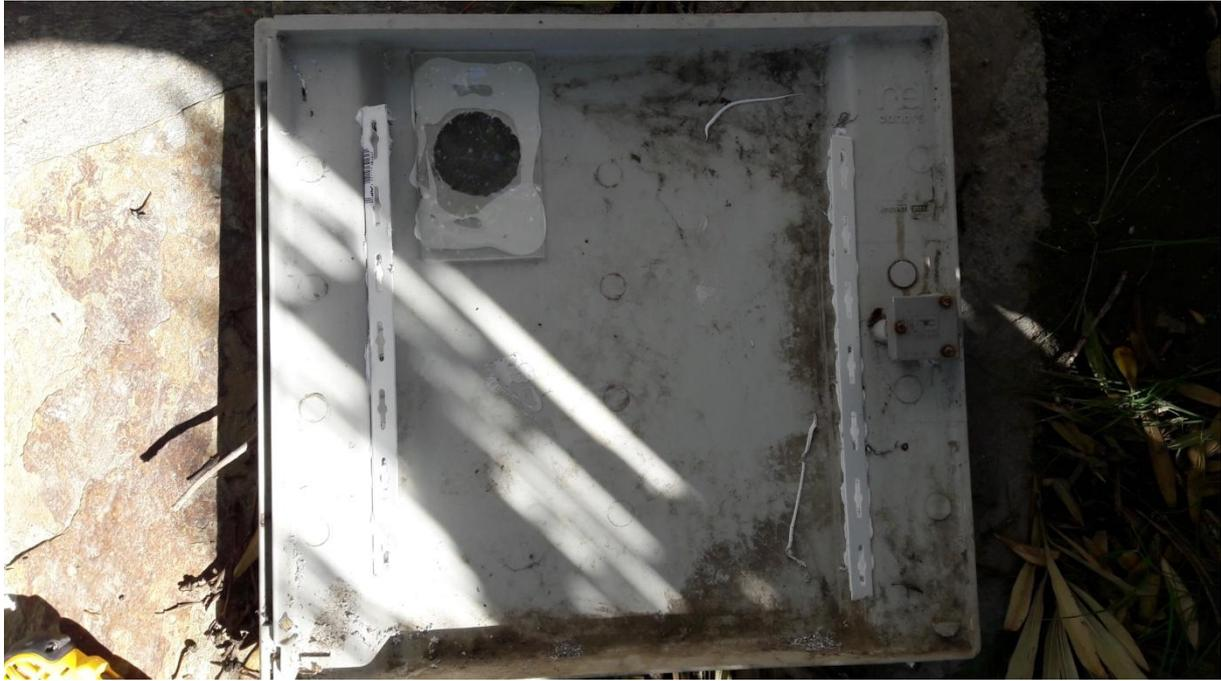
**Figure 4** Côté intérieur de la porte avec les deux cornières boulonnées et collées, et mise en place d'un regard pour voir les chiffres en cas de compteur mécanique. Regard constitué d'un plexiglas transparent collé sur la porte côté intérieur.
