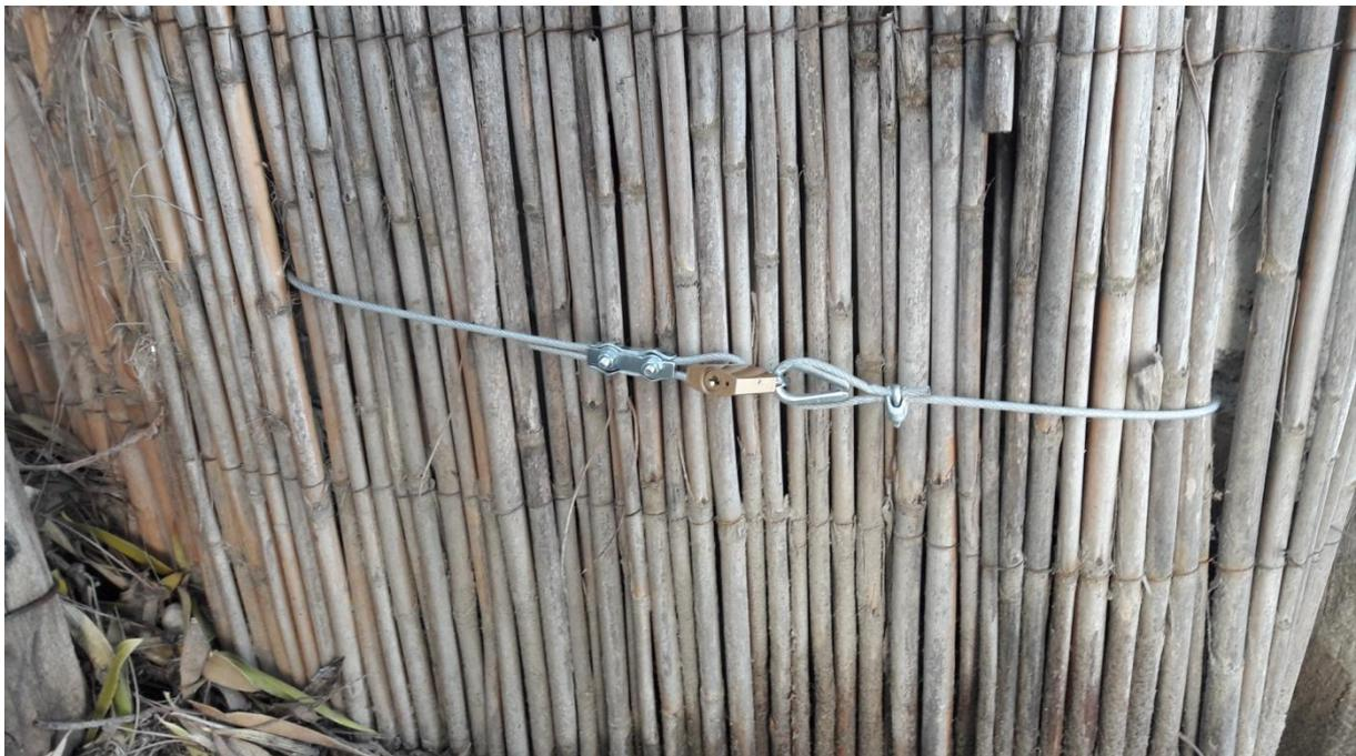
Figure 7 Vu de l'arrière du coffret une fois le travail terminé : en fait à l'intérieur de l'armoire , forer de chaque côté du panneau en bois (support du compteur) un trou de 6 mm de diamètre. Dans ces trous faire passer le câble acier (diamètre 4 mm plastifié) et à l'arrière du coffret faire un œillet de chaque côté du câble et mettre un cadenas.
